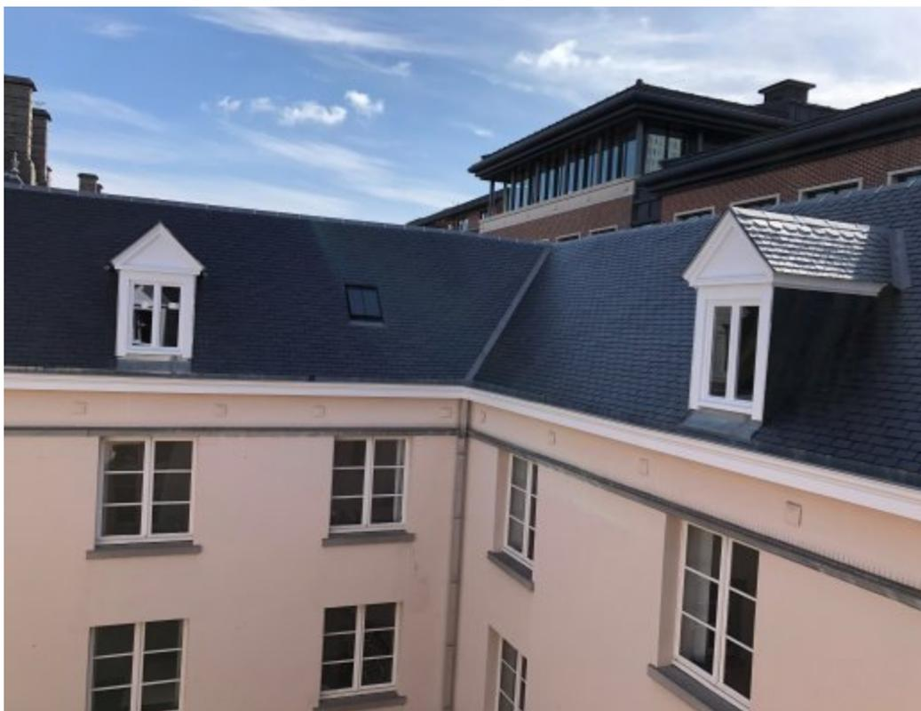
La couverture de toiture en ardoises était arrivée en fin de vie et a donc également été remplacée par de nouvelles ardoises. Cette rénovation a aussi été l'occasion d'installer un nouveau système anti-pigeon et de remplacer les descentes d'eau de pluie. Les lucarnes et les lanterneaux ont été refaits.
