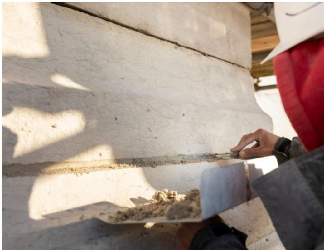
Dans le but d'éviter de futures infiltrations d'eau, le jointolement sera également refait en grande partie. Les surfaces de pierres horizontales seront donc recouvertes d'un revêtement étanche à l'eau.
